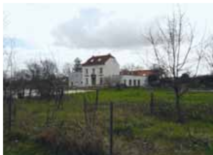
Der Borreshof, der erstmals 1378 urkundlich erwähnt wird, ist der einzige heute noch vorhandene Vierkanthof Düsseldorfs. Er liegt am Aderdamm, der in den Aderräucherweg und dann in den Krahkamp-Weg übergeht.
