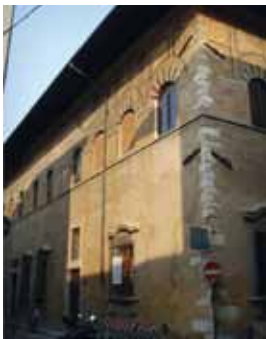
Altes Archivgebäude der Firma Datini in Prato
