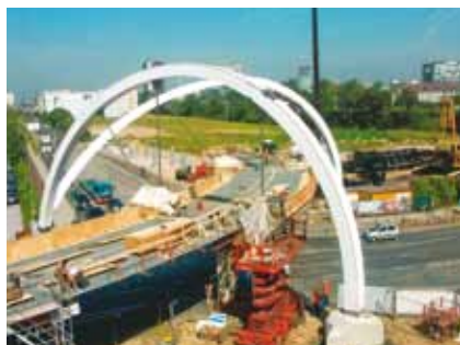
05.07.2011 – Fertig montierte Brückenbögen.
