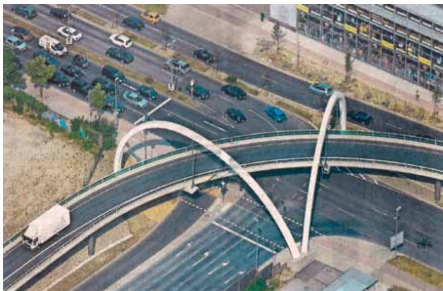
Foto aus WZ vom 31.07.2013 – Vogelperspektive der fertigen Hochstraße, genannt ÜBERFLIEGER
