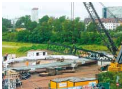
29.06.2011 – Auf dem ehemaligen Kleingartengelände wurden Brückenteile und die Brückenbögen fertig montiert.
