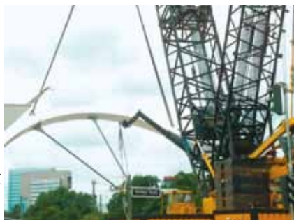
02.07.2011 – Einschwenken der vormontierten Brückenbögen.
