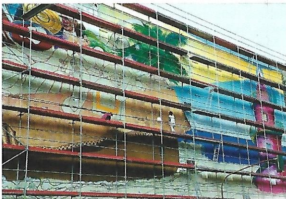
Beginn der Malerarbeiten
