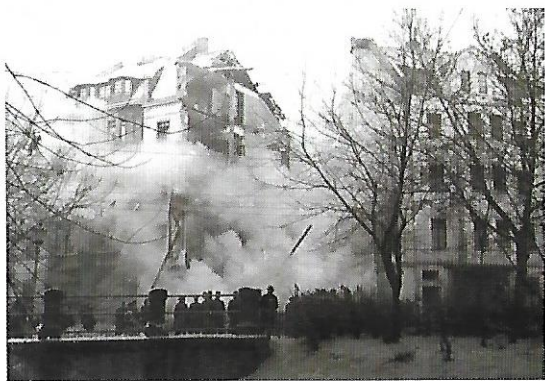
Bombenschaden am 04.02.1941 Ecke Aachener Straße und Karolingerstraße
