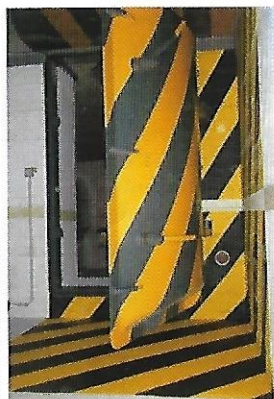
Eine der Schleusentüren
