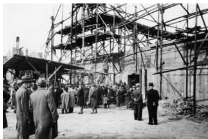
In Erwartung eines Luftangriffs vor dem Bunker an der Moltkestr./Eulerstr. 1944
