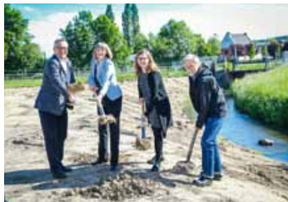
Erster Spatenstich an der Südlischen Düssel
