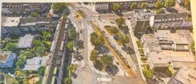
Der Aachener Platz wird nach dem Umbau ein Mobilitätsstation. Auf der gegenüberliegenden Seite ist eine Bushaltestelle zu sehen.
