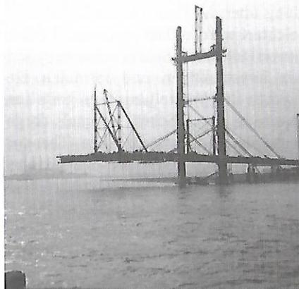
*Der Bau der Strombrücke mußte unterbrochen werden, da sich die Brückentafel sichtbar absenkte. Fotos Rolf Hackenberg*
