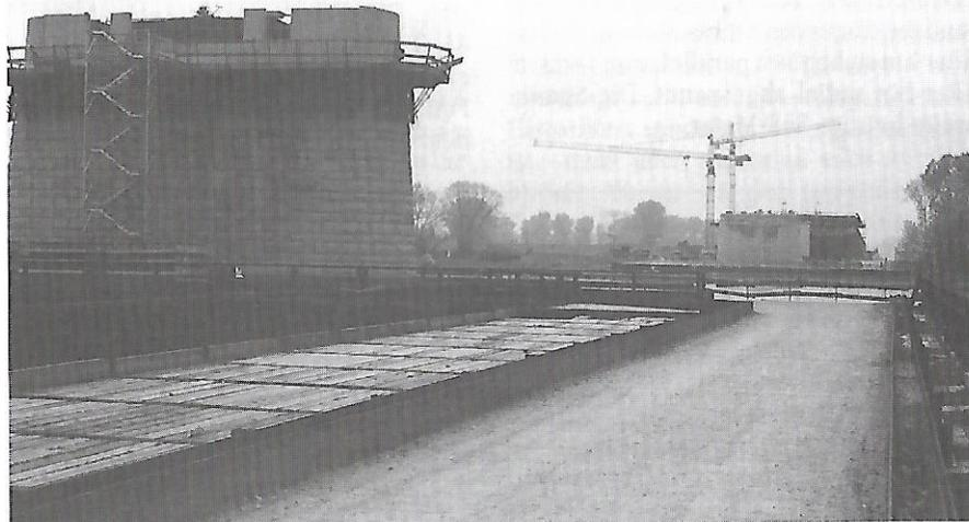
Erst werden die Vorlandbrücken bis an die Strompfeiler heran gebaut, dann beginnt der Bau der Strombrücke.
