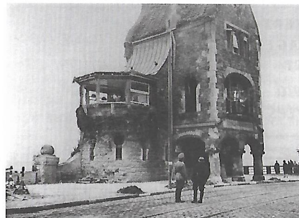
Nach der Zerstörung der Feuerwache Akademiestraße dient das Düsselschlösschen als Unter- kunftsgebäude für die Wachbesatzung
