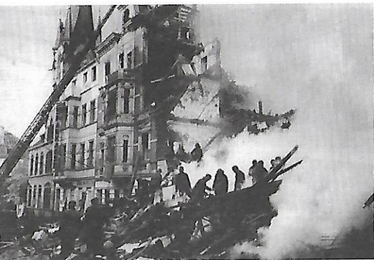
Ganze Häuserzeilen sind nach den Luftangriffen zerstört.
