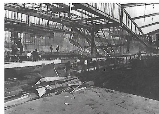
Der Hauptbahnhof ist nach den ersten Bombenangriffen teilweise zerstört.
