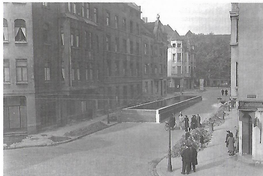
In den Straßen wird in aufgemauerten Bassins Löschwasser gesammelt
