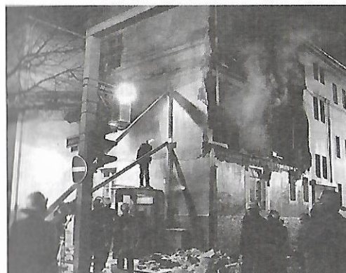
Eine Propangasflasche löst die Explosion aus und reißt die Hauswand über zwei Etagen weg
