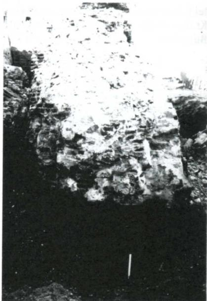
Querschnitt durch die Mauer der Bastion, darunter Pfahlrost aus Eichenstämmen, die als Bauuntergrund dienten (1636)
