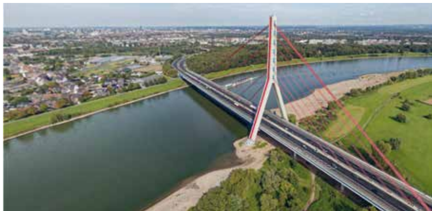
Die Fleher Brücke (Bestandsbrücke)
