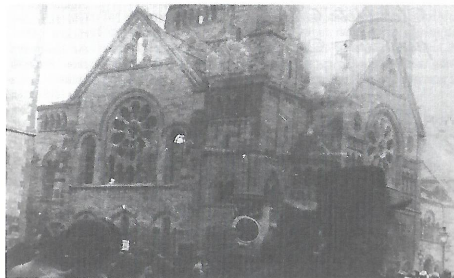
Die Synagoge brennt bis auf die Grundmauern nieder, ohne dass die Feuerwehr entscheidend eingreift.
